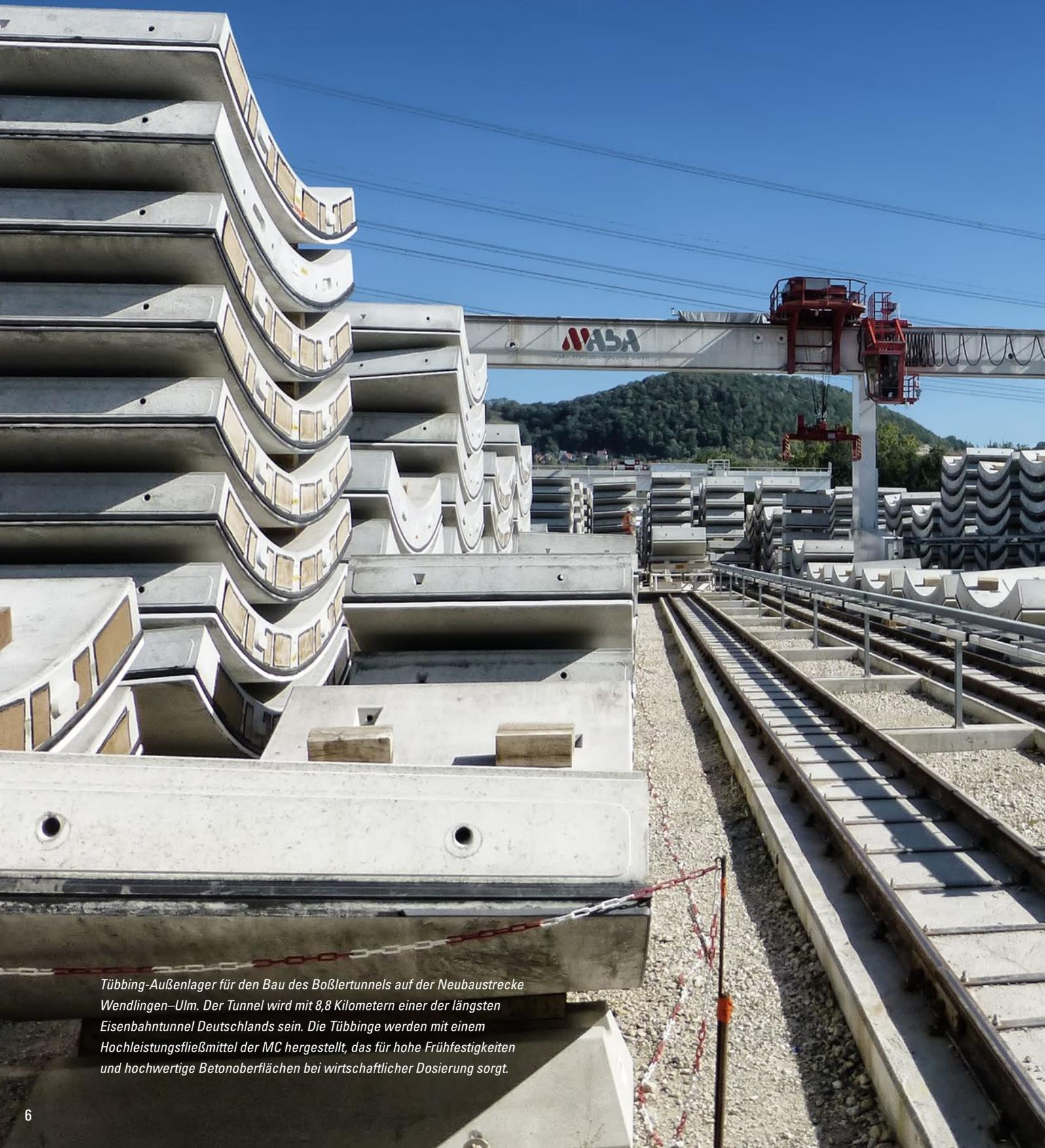
*Tübbing-Außenlager für den Bau des Boßlertunnels auf der Neubaustrecke Wendlingen–Ulm. Der Tunnel wird mit 8,8 Kilometern einer der längsten Eisenbahntunnel Deutschlands sein. Die Tübbinge werden mit einem Hochleistungsfließmittel der MC hergestellt, das für hohe Frühfestigkeiten und hochwertige Betonoberflächen bei wirtschaftlicher Dosierung sorgt.*
