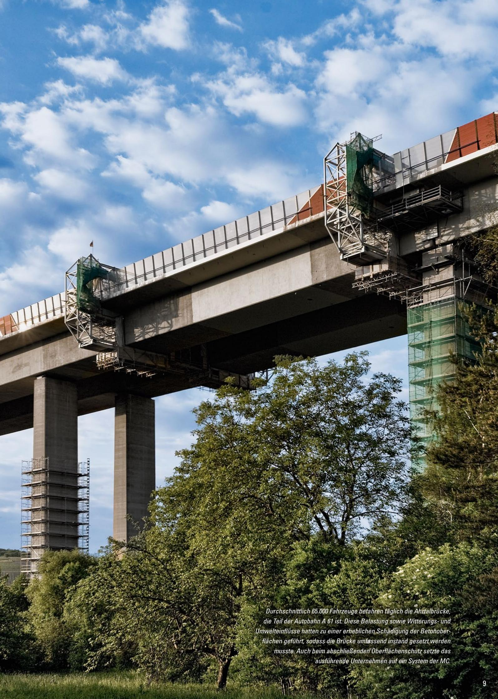
*Durchschnittlich 65.000 Fahrzeuge befahren täglich die Ahrtalbrücke, die Teil der Autobahn A 61 ist. Diese Belastung sowie Witterungs- und Umwelteinflüsse hatten zu einer erheblichen Schädigung der Betonoberflächen geführt, sodass die Brücke umfassend instand gesetzt werden musste. Auch beim abschließenden Oberflächenschutz setzte das ausführende Unternehmen auf ein System der MC.*
