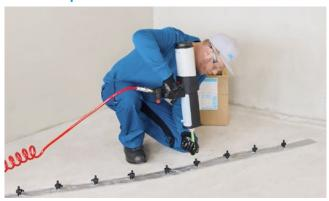
Rissinjektion mit MC-Fastpack 2300 top über MC-Hammer Packer LP 12 am nassen Bauteil
