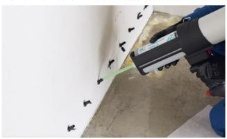
Flächeninjektion mit MC-Fastpack 2700 über MC-Hammer Packer LP 12 in einen feuchten Hohlraum
