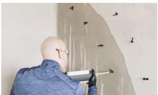
Hohlrauminjektion mit MC-Fastpack Injekt LE über MC-Hammer Packer LP 12 am Wasser führenden Bauteil
