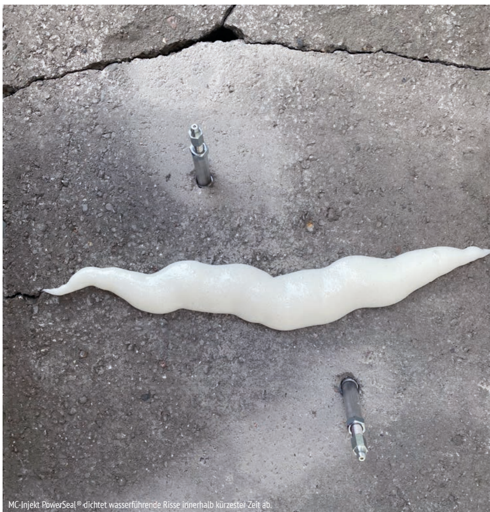
MC-Injekt PowerSeal® dichtet wasserführende Risse innerhalb kürzester Zeit ab.
