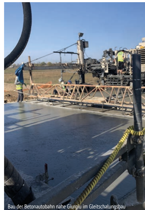
Bau der Betonautobahn nahe Giurgiu im Gleitschalungsbau
