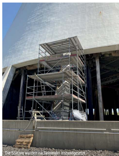
Die Stützen wurden nacheinander instandgesetzt.
