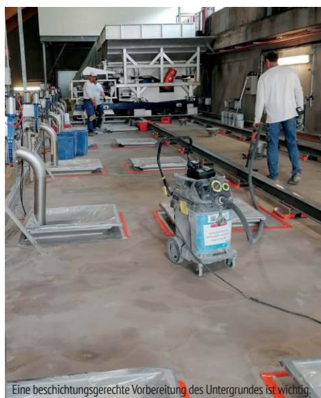
Eine beschichtungsgerechte Vorbereitung des Untergrundes ist wichtig.
