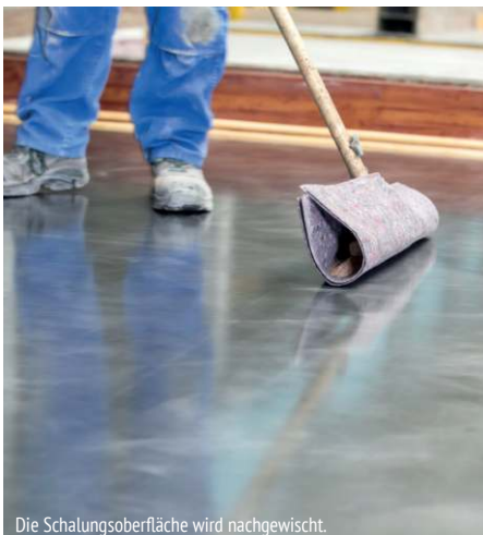
Die Schalungsoberfläche wird nachgewischt.
