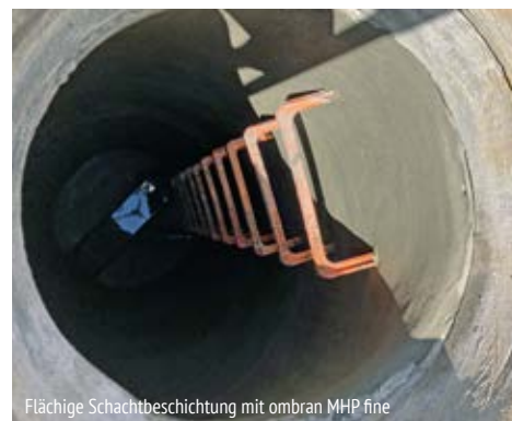
Flächige Schachtbeschichtung mit ombran MHP fine
