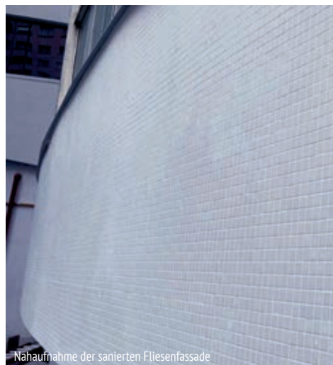
Nahaufnahme der sanierten Fliesenfassade
