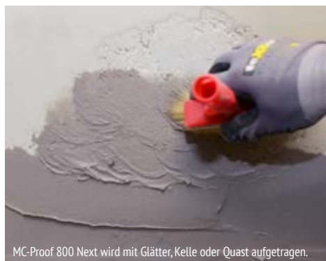
MC-Proof 800 Next wird mit Glätter, Kelle oder Quast aufgetragen.
