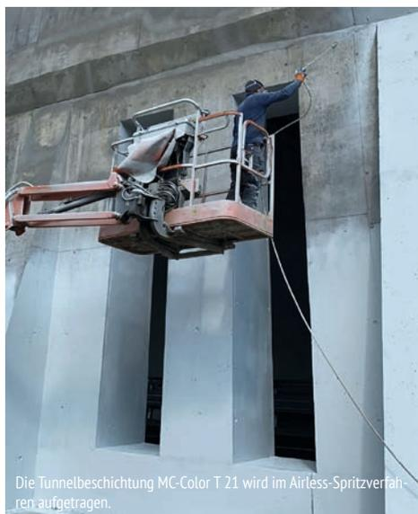
Die Tunnelbeschichtung MC-Color T 21 wird im Airless-Spritzverfahren aufgetragen.
