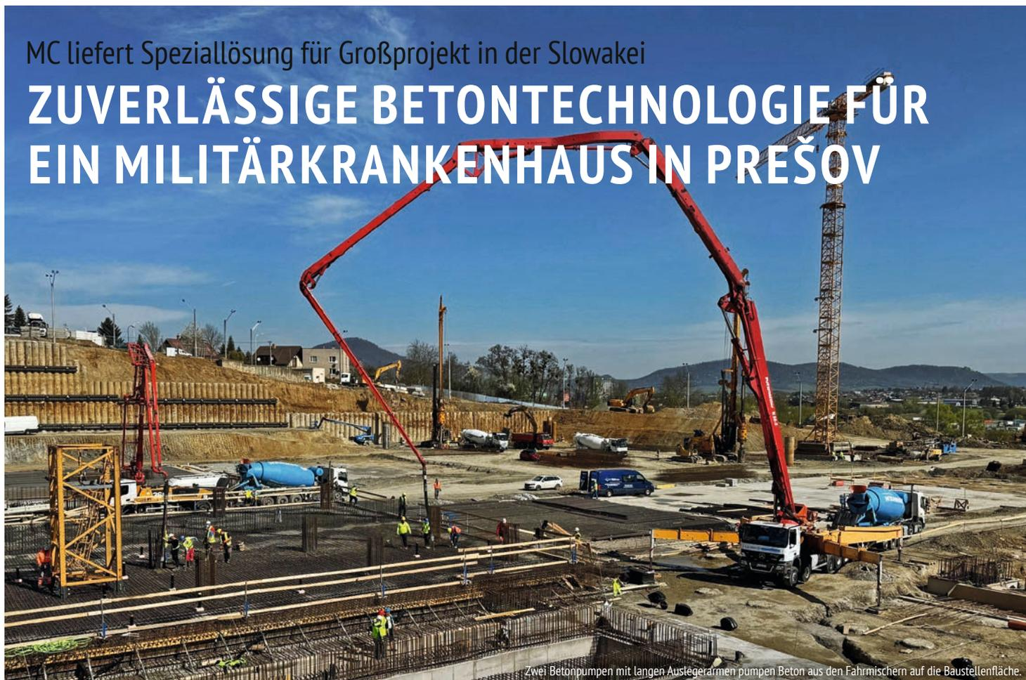
Zwei Betonpumpen mit langen Auslegerarmen pumpen Beton aus den Fahrmischern auf die Baustellenfläche.
