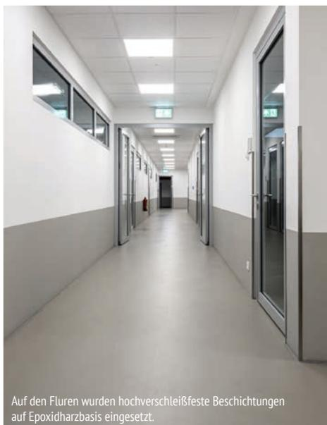
Auf den Fluren wurden hochverschleißfeste Beschichtungen auf Epoxidharzbasis eingesetzt.
